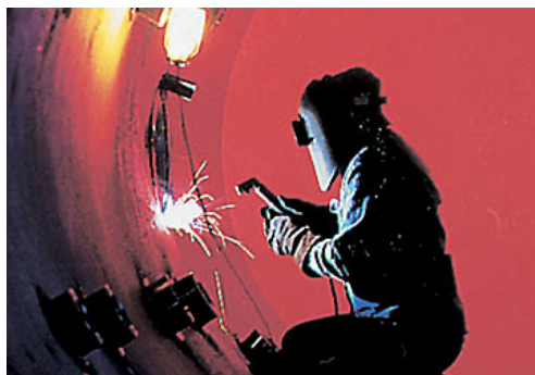
ガス溶接(船舶)
